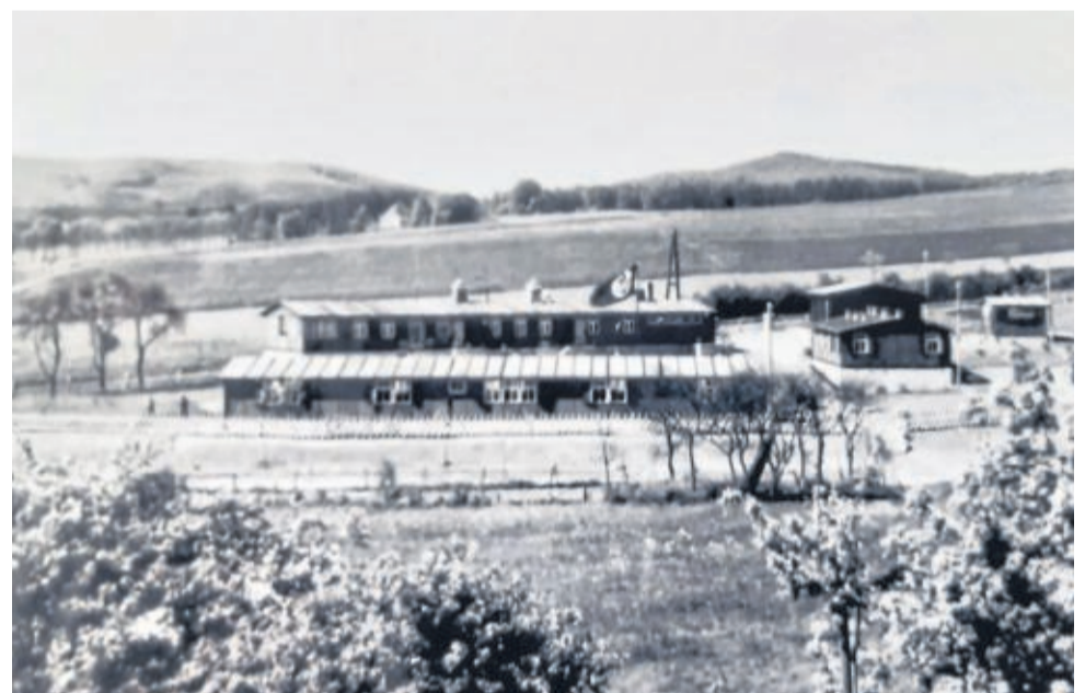
Bevor in den Hallen „Am Goldrain“ produziert wurde, war der Bau ein Reichsarbeitsdienstlager für junge Frauen.
